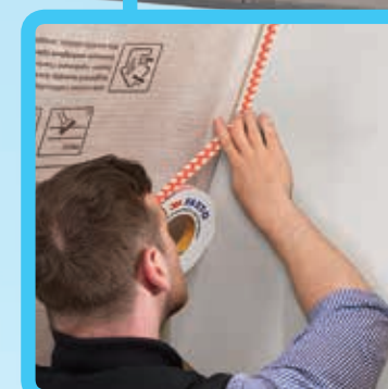
Приклейка пароизоляционных мембран к оштукатуренным поверхностям – просто и быстро с помощью двухсторонней ленты: 3M™ FAST-D 8069E
