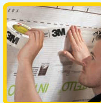
Герметичное соединение между мембраной и стыками за один шаг: 3M™ FAST-G 8068E
