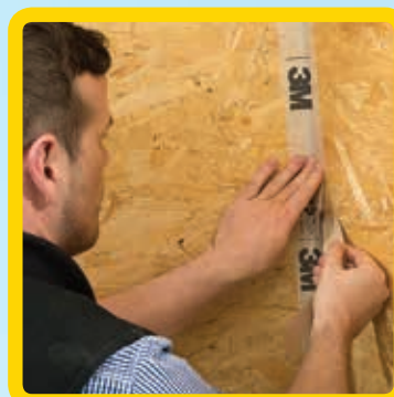
Герметизация стыков и разрывов как внутри, так и снаружи: 3M™ FAST-G 8068E
