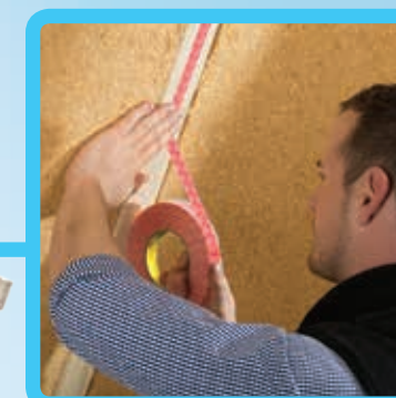
Герметичное соединение между стропилами и строительными мембранами как внутри, так и снаружи, без использования гвоздей с двухсторонней лентой: 3M™ FAST-D 8069E
