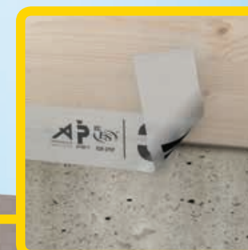
Герметизация наружных стыковых соединений: 3M™ FAST-G 8068E
