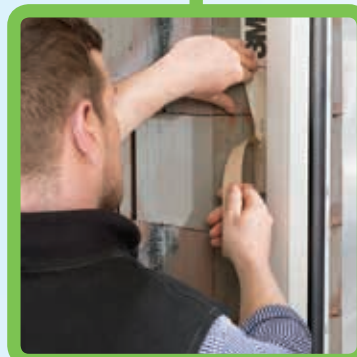
Герметизация оконных и дверных проемов изнутри при реконструкции: 3M™ FAST-F 8067E
